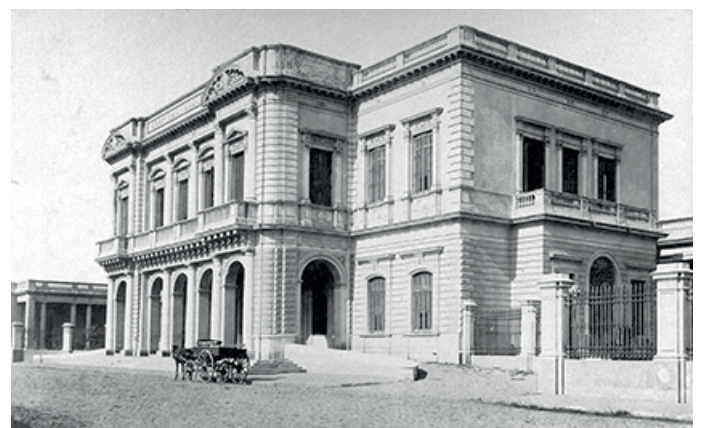
Hospital Militar Central (1898 – 1939) sito en Combate de los Pozos 2113 (Buenos Aires) Arq. Francesco Tamborini
